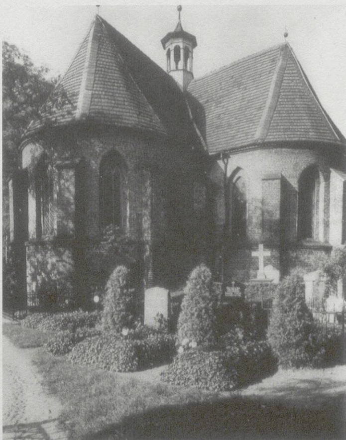
10. Bernstadt (Bierutów), Begräbniskirche, 1622-1631 (seit 1945 ruiniert). Außenansicht vom Nordosten (Archivfoto).
