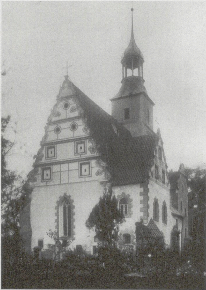
11. Rothsürben (Żórawina), Dreifaltigkeitskirche, 1597-1604. Außenansicht von Osten (Archivfoto).
